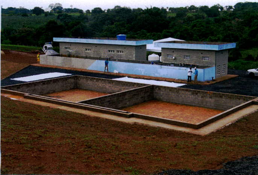
Estação de Tratamento de Esgoto de Ipanema.
