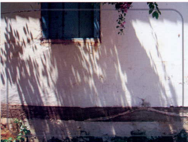
F.47 - Vista Sede da Fazenda Capim Branco e ao lado o depósito F.48 - Baldrame de madeira da sede
