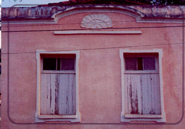
F. 62 - Residência D a . Margarida Alves Borges F. 63 - Detalhe do elemento decorativo da fachada
