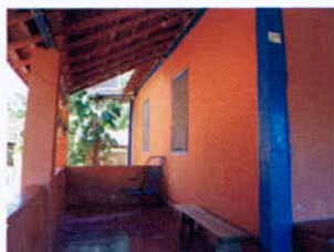
Cunhal de madeira na fazenda Barra Grande
