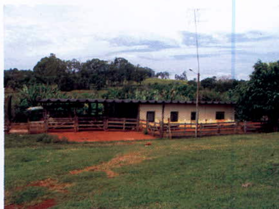
Atual sede da Fazenda Laje - Tenda do Moreno
