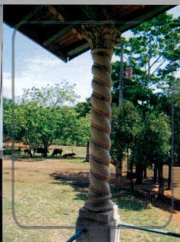
F.45 - Colunas que separam as salas de estar e jantar F.46 - Detalhe da coluna na varanda frontal
