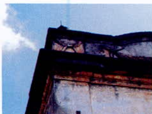
Cimalha na casa do Capitãozinho - Martinésia
