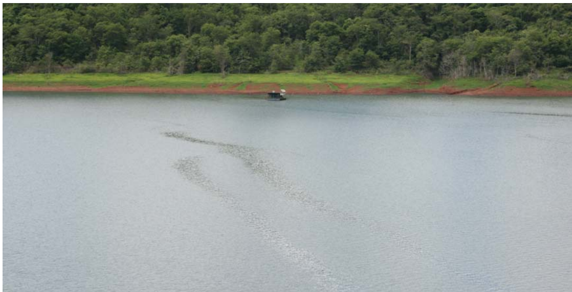
Foto 20: Reservatório da Usina Hidrelétrica de Nova Ponte
