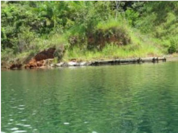
**Figura 10.4.ae – Vista geral do dispositivo de contenção no Ponto 16. Notar utilização de sacaria.**
