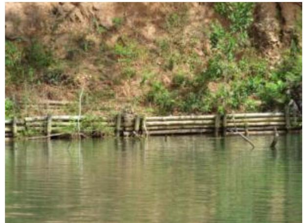
**Figura 10.4.v – Detalhe do dispositivo de contenção do tipo paliçada.**
