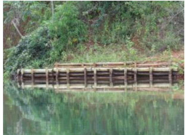
**Figura 10.4.ab – Detalhe da paliçada de contenção.**
