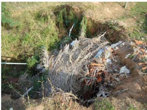
**Figura 10.4.p – Feição erosiva preenchida por entulho de construção civil.**
