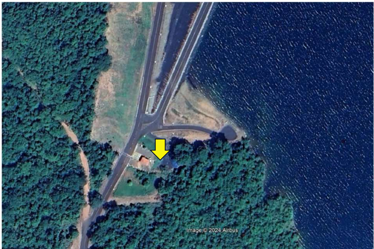
Figura 08 – Sala de Encaminhamento de Emergências (X: 770.159 Y: 7.933.901)
