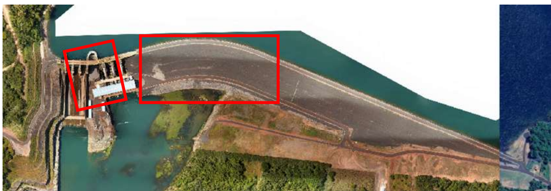
Figura 11. Locais susceptíveis a falha – Barragem principal e Tomada D'Água. Fonte: Ortofotos (CF Engenharia, 2023).
