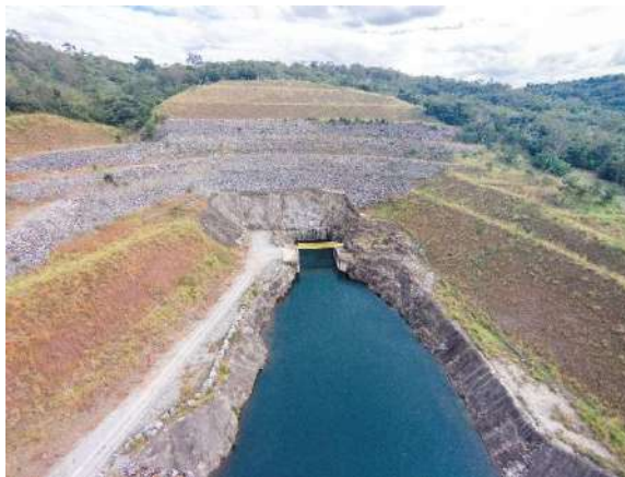
Figura 03 – Vista do canal de adução que conduz água para câmara de carga através do túnel de adução escavado em rocha.
