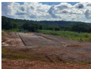
Vista do pátio após retirada dos resíduos - UHE Amador Aguiar II.
